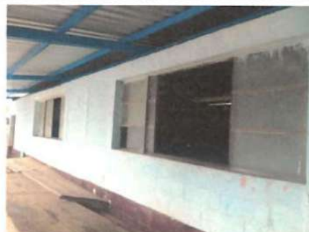
Foto 2: Sustrucción de ventanas; sistema de apertura: Corredizas, Perfiles color blanco estandar, Material del marco: PVC Material de la ventana: Vidrio, sellado perimetral.
