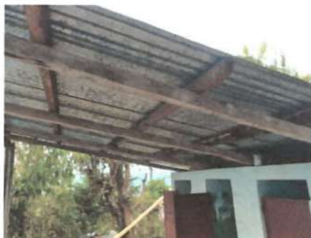
Foto 1: Sustrucción de cubierta de techo con lámina galvanizada, Tipo de lamina: troquelada Calibre: 26, incluye: fijaciones y sellado en traslapes.
