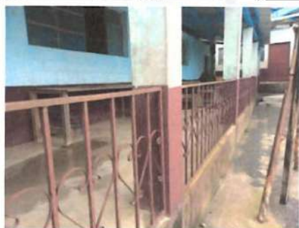
Foto7: Mantenimiento a barandales metálicos, incluyendo lijado y pintura.
