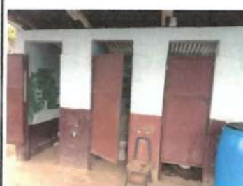
Foto 6: Mantenimiento a puerta metálica existente retiro de óxido, suciedad y pintura deteriorada; incluye cepillado, lijado y aplicación de pintura
