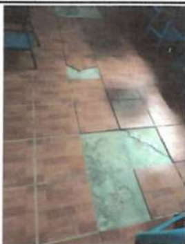
Foto 3: Sustrucción de piso cerámico por piso cerámico.
