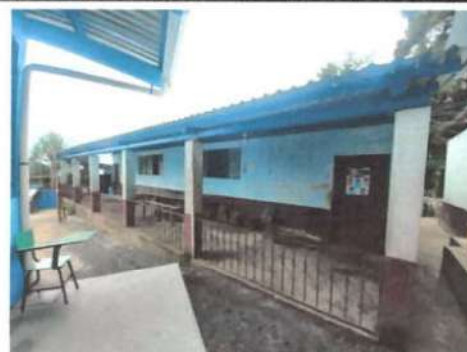
Foto 4: Preparación de la superficie y aplicación de pintura a dos manos, en paredes interiores y exteriores del establecimiento.
