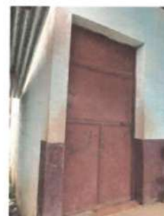
Foto 6: Mantenimiento a puerta metálica existente retiro de óxido, suciedad y pintura deteriorada; incluye cepillado, lijado y aplicación de pintura
